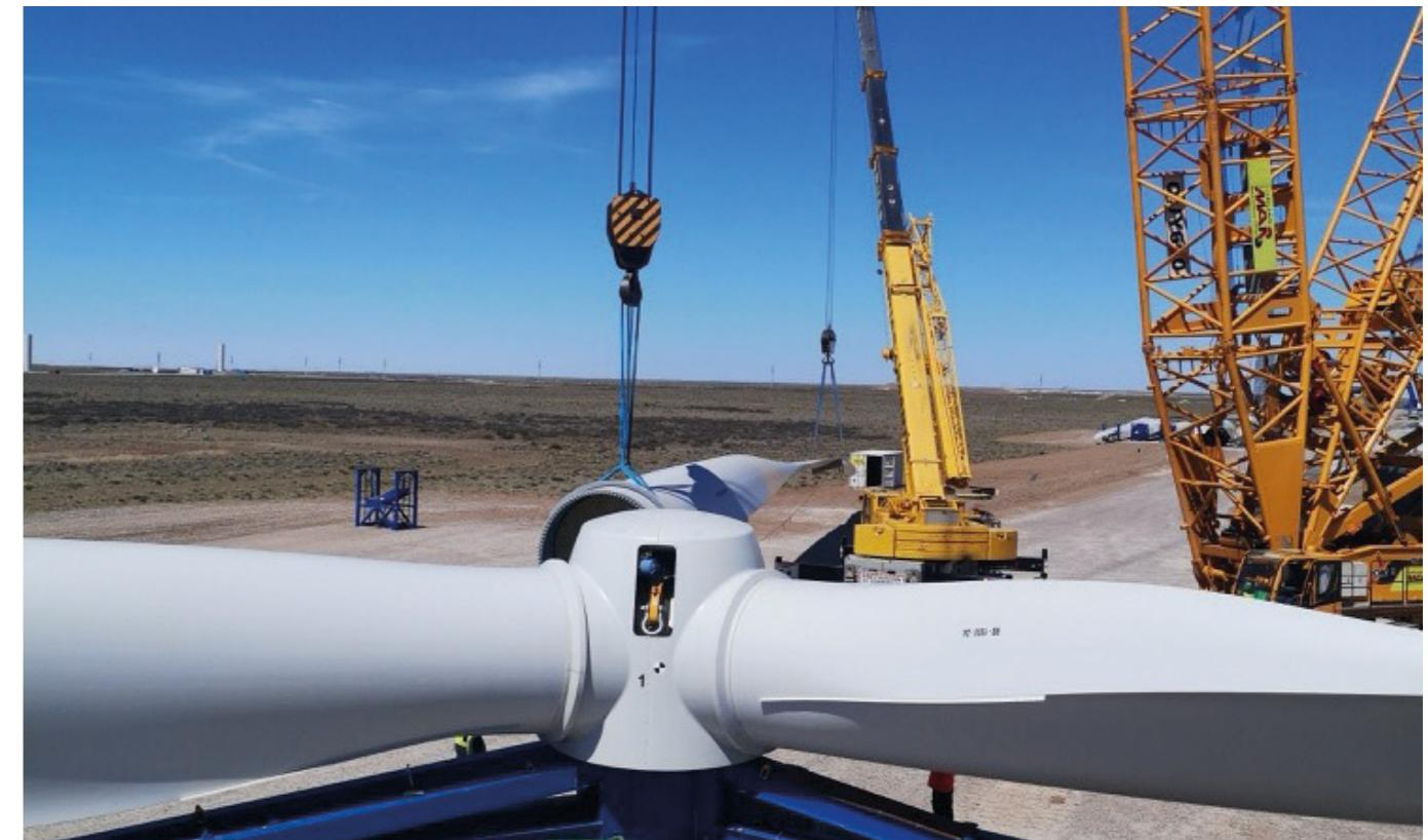
**IRON** Group posee una division llamada **IRON Heavy Lifting** que hoy y respondiendo al gran programa de generación eólica que se puso en marcha en Argentina, está totalmente abocada al servicio de montaje y conexión electromecánica de equipos de generación eólica.
